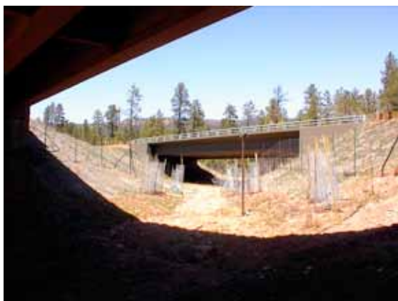
Pasos de vida silvestre “viaductos” en Arizona
